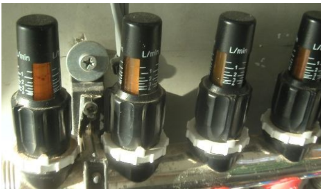
7. kép: kétéves, a legmodernebb csőrendszerrel szerelt padlófűtés rendszer. A bebarnult rotaméter-ablakok bakteriális szennyeződésre utalnak.
