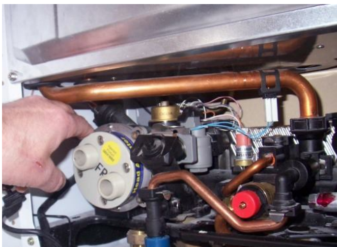
8. kép: a szivattyúfej-adapter a keringető szivattyú motorjának helyére beszerelve.
