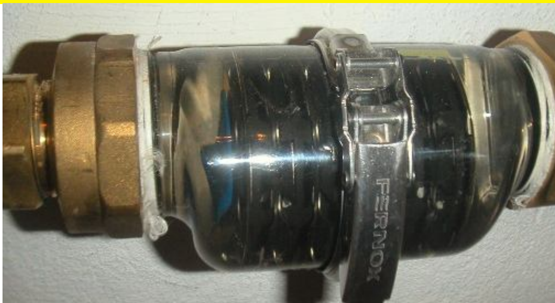
12. kép: a Bolier Buddy a visszatérőágba építve. Lássuk, mi van belül! Nyugodtan alhatunk a kazánunk biztonságban.
