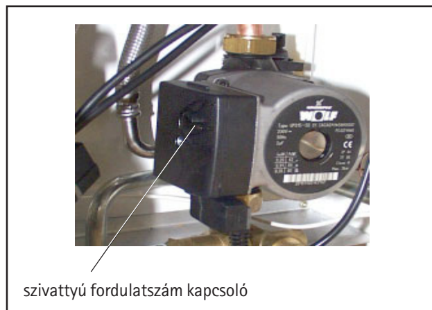
Ábra: a 3-fokozatú szivattyú fordulatszám kapcsolója
