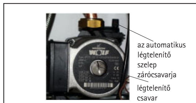
Ábra: a szivattyú légtelenítő szelepe
