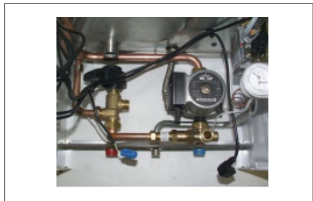
Ábra: a csatlakozó készlet kiszérése
