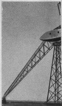
8. ábra. A Krim-ben (Balaklavában) 1931-ben felállított 100 kW-os szovjet szélérőmű
