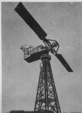
9. ábra. 1000 kW teljesítményű amerikai szélérőmű „Smith — Putnam szélturbina”
