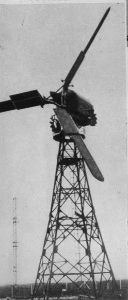
11. ábra. 130 kW teljesítményű Neyrpic D-21 típusú szélérőmű. Cherbourg, Franciaország
