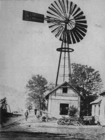
7. ábra. Amerikai rendszerű soklapátos, lassújárású szélmotor, főleg vízszivattyúzásra
