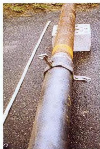
25. ábra. A feszítőkötelek felső tartógyűrűje, befűzött kötélzsorítókkal
