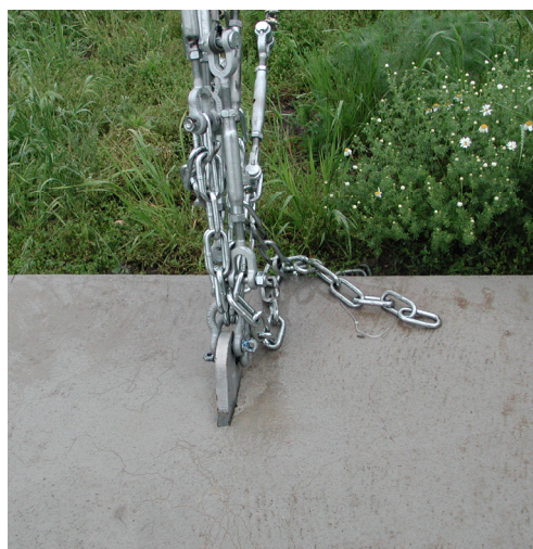
b) Feszítő sodronyok rögzítése a talajon, erre a célra készített beton alapzaton
