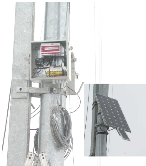
c) A toronyon elhelyezett villamos szerelvények és a tápellátást biztosító napelem
