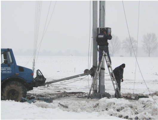
a) A torony felállításához használt UNIMOG és a szerelvényezés
