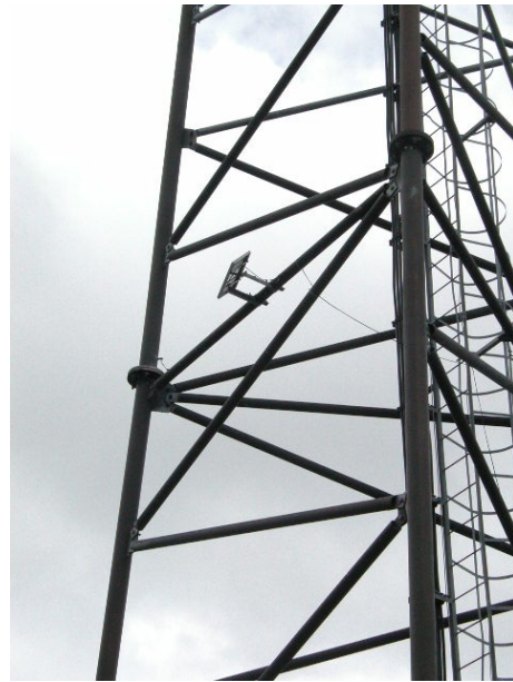
b) Az adatrögzítő feszültségellátását biztosító napelem (Ajka, GSM torony)
