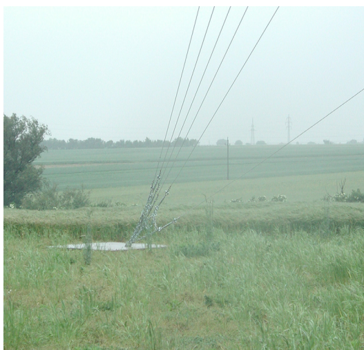
a) A torony több oldalról, több ponton ki van feszítve
