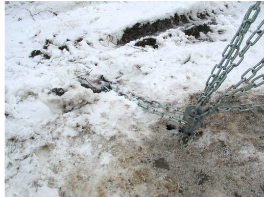
b) A torony kifeszítésére szolgáló sodronyok rögzítése a talajon
