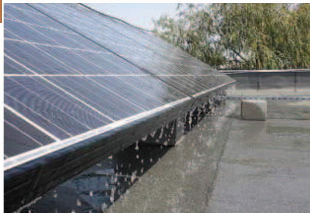
1. ábra Napelemtáblák felületének hűtése
