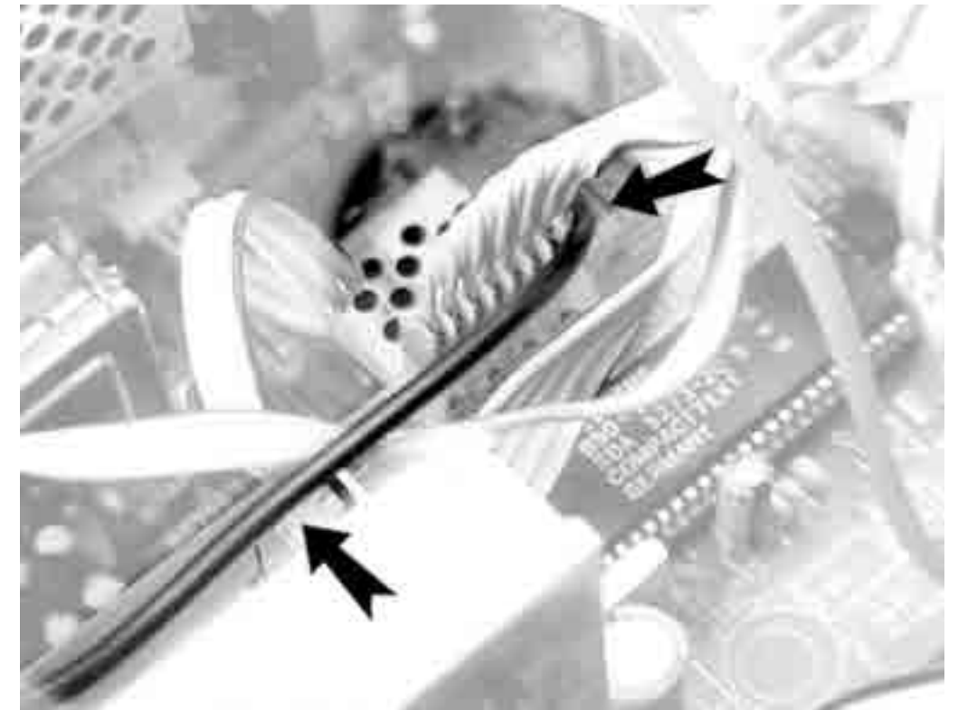
Masseleitung zwischen ASIS Kabel durchführen / Lay the ground cable between the ASIS cable
