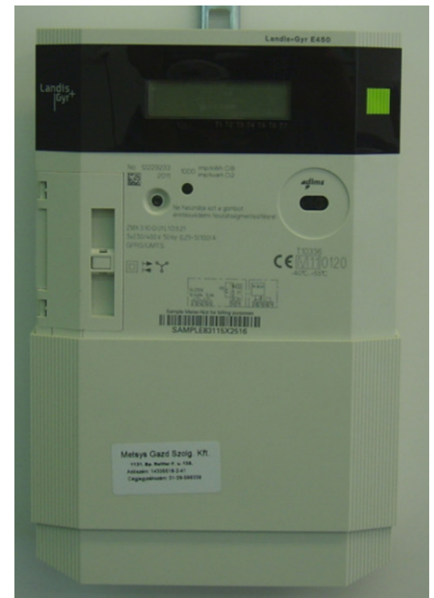
3 fázisú, típusa, E450 3x5-100 A Kommunikáció: GPRS.
